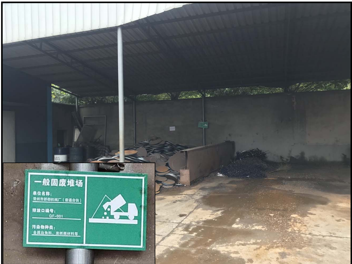
东厂界处一般工业固废堆场及环保标识牌
