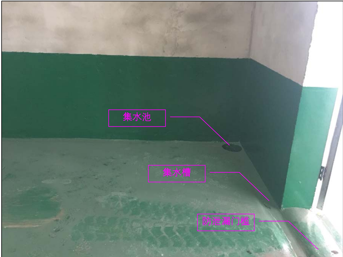
危废堆场内已设置防泄漏门槛、集水槽和集水池
