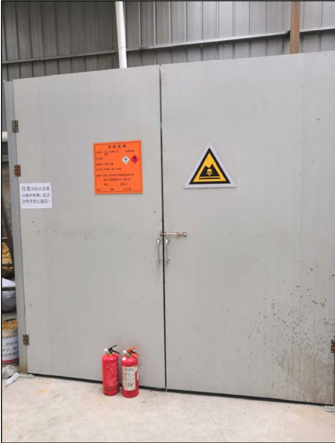
危险废物堆场及环保标识牌
