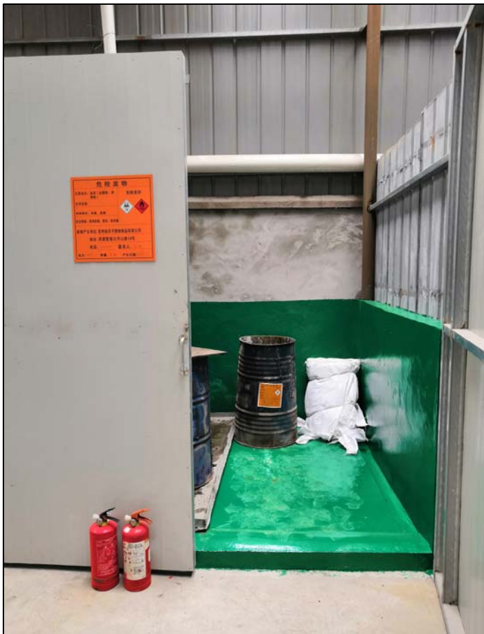
危险废物堆场地面墙面已做防腐防渗处理
