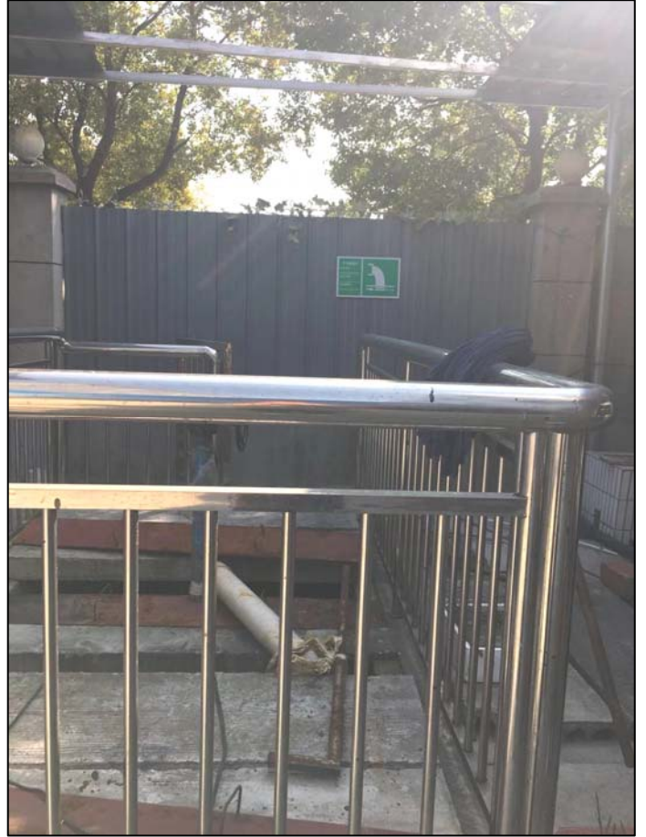
东北厂界处三格式化粪池、 污水排放口及环保标识牌
