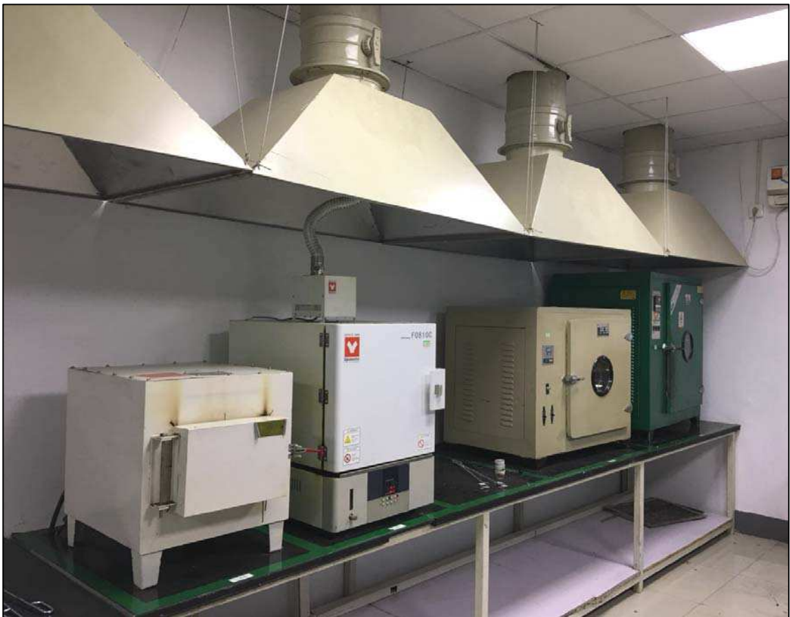
实验室马弗炉测试工段集气罩
