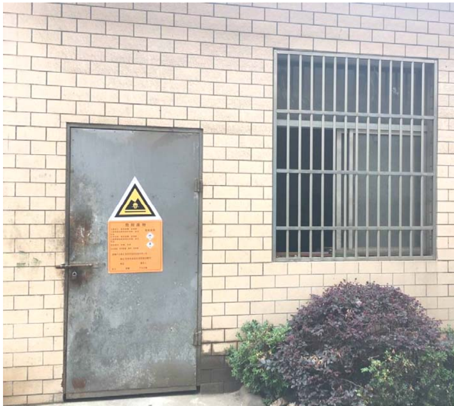
危废堆场及环保标识牌
